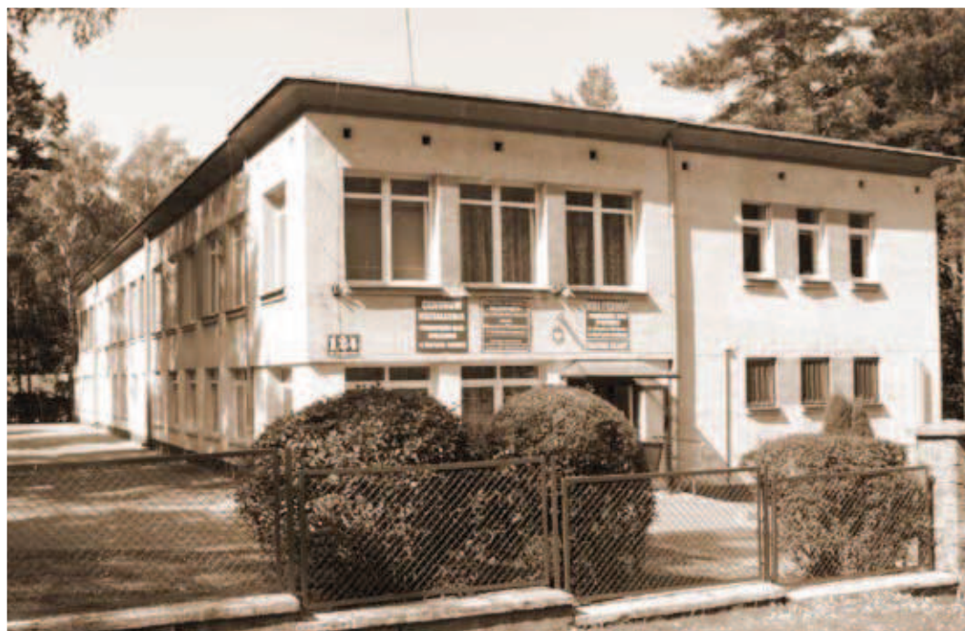
Budynek szkoły przy ul. Legionów 124 - stan obecny (2011)
